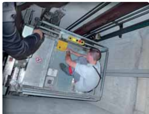
Intervention de deux techniciens spécialisés sur le toit d'une cabine d'ascenseur, pour la mise en place un module d'interphonie.
