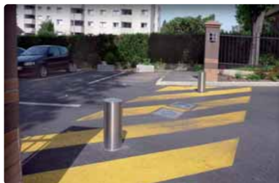
Pose de bornes encastrées et télécommandées à l'entrée d'un parking.
